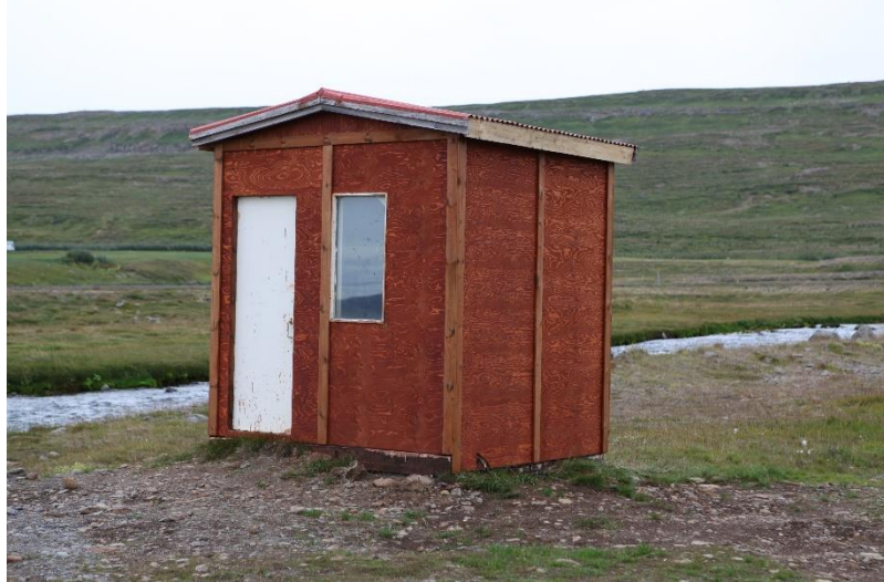
Mynd 2.3. Brunnhús byggt ofan á brunn en út frá honum ganga drenlagnir.
