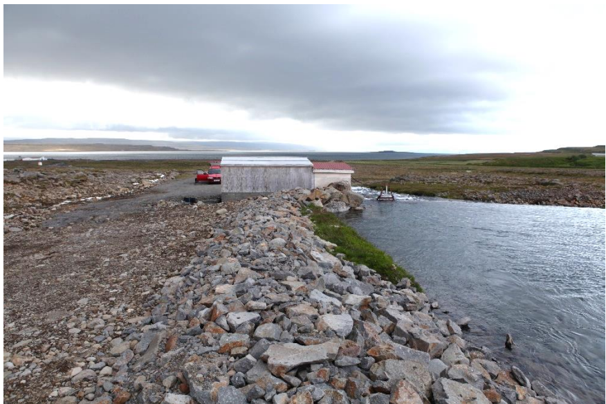
Mynd 2.4. Stífluhús fyrir miðri mynd og svæðið þar sem drenlögn er staðsett er ofan við húsið til vinstri á myndinni.
